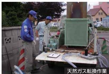
天然ガス転換作業
