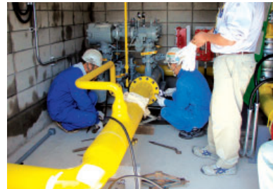
ガス配管工事
