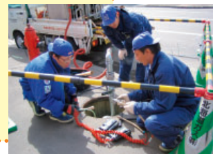
天然ガス転換作業の様子
