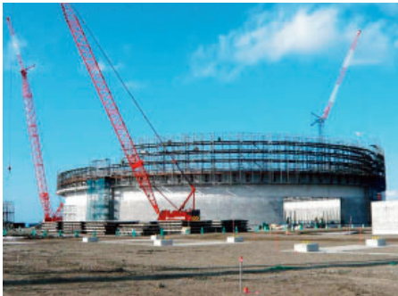
順調に工事が進む石狩LNG基地
