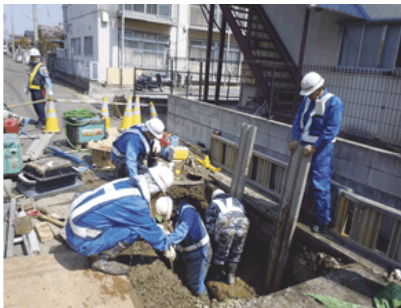
ガス導管の修繕作業(仙台市)
