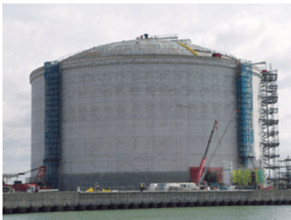
建設中のLNGタンク
