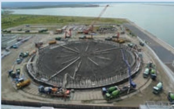
「2号タンクの基礎版工事」
