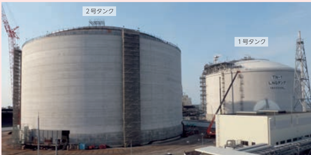
<石狩LNG基地>
