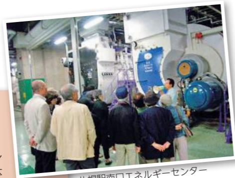
札幌駅南口エネルギーセンター
