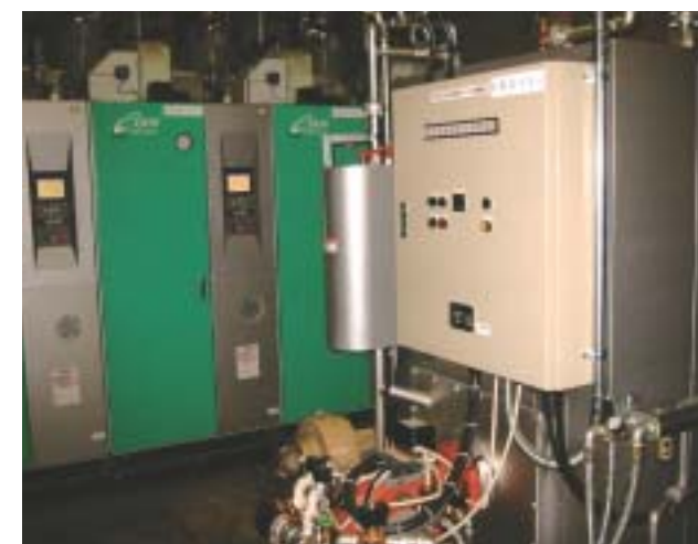
重油ボイラーを天然ガスボイラー（写真奥）と廃油ボイラー（写真手前）に転換し、年間1600tのCO 2 を削減（食品工場） 「エネルギー多消費型設備天然ガス化推進補助事業」の補助金を受けて建設
