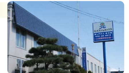
北ガスジェネックス社屋の太陽光パネル
