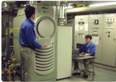
28kWマイクロタービン実証試験
