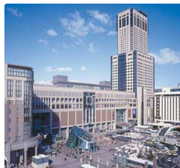
JRタワー（札幌駅南口）
