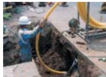
非開削工事現場
