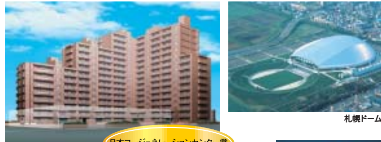
ガスコージェネレーション導入施設例
