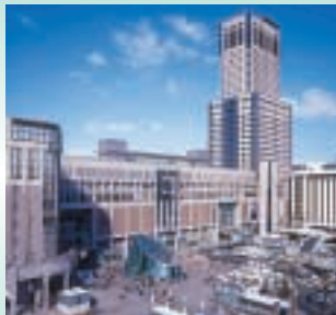
札幌駅南口JRタワー (コージェネレーション)
