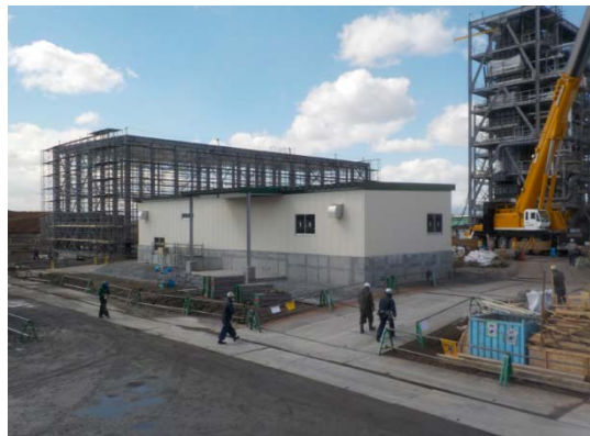
苫小牧バイオマス発電 建設現場
