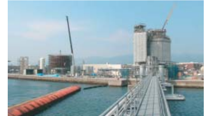
函館みなと工場の建設
