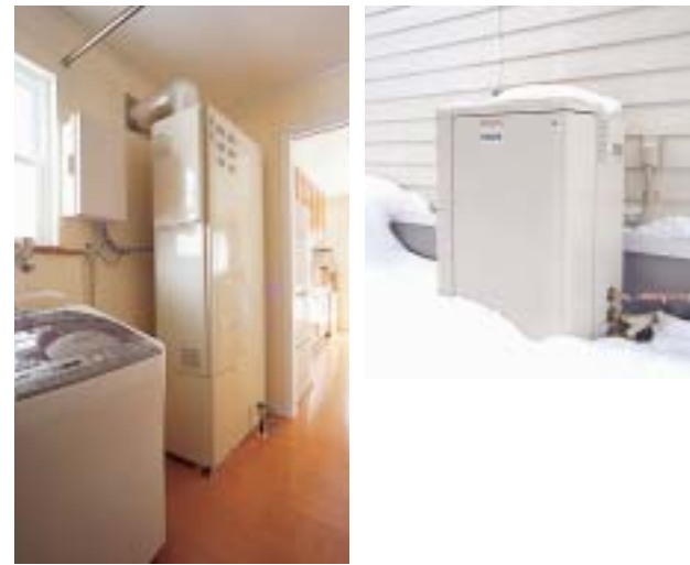
排熱利用給湯暖房ユニット
