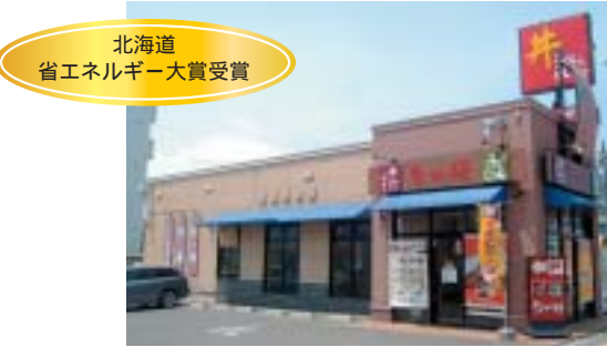
ガスコージェネレーション導入施設例
