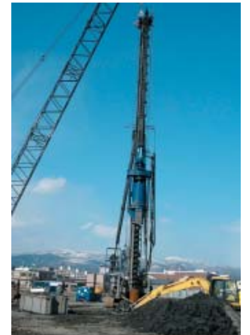
低振動型工法・低騒音型重機を採用した現場
