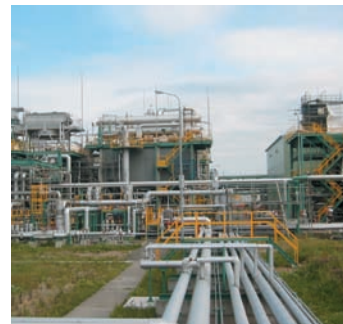
天然ガス精製施設
