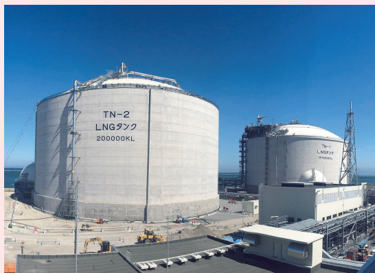
左が2号タンク、右奥が1号タンク
