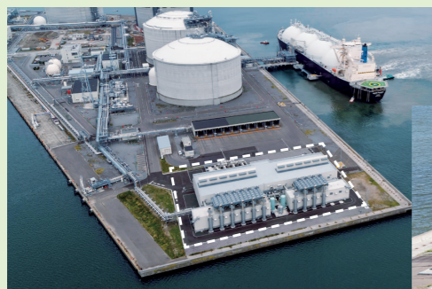
石狩LNG基地
