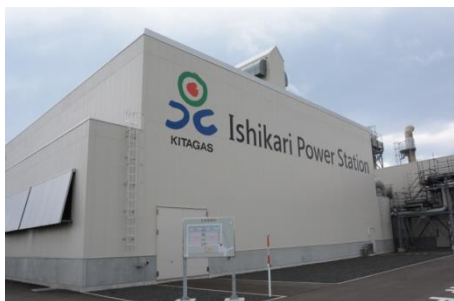
「北ガス石狩発電所」
