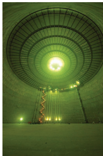
【LNGタンク内部】
