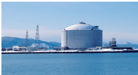
【石狩LNG基地】
