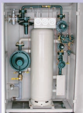
【小型ガス発生設備】
