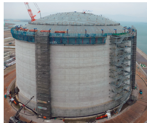
石狩LNG基地2号タンク建設工事中
