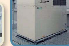
天然ガスコージェネレーションシステム
