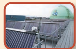
屋上に設置されたソーラー集熱パネル
