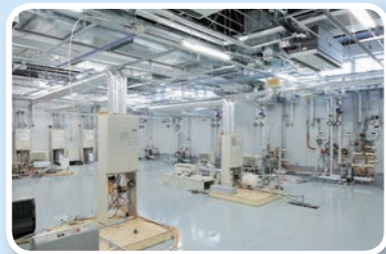
ガス機器実験室
