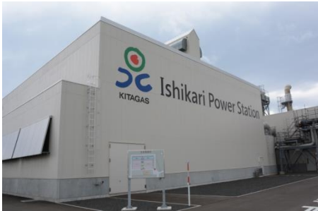
「北ガス石狩発電所」
