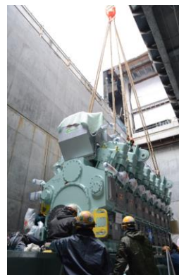
札幌発電所(天然ガスコージェネレーション)
