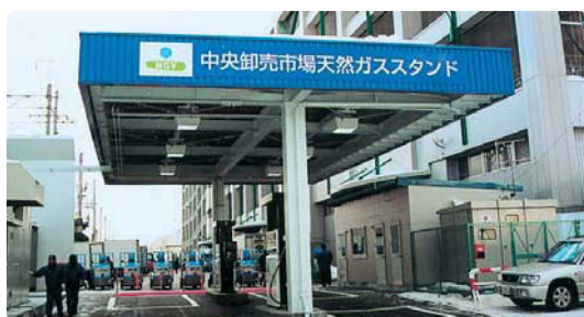
北ガスが運営する市場敷地内の天然ガススタンド
