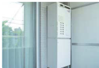
Fact 高効率ガス熱源機(約10%効率向上)
