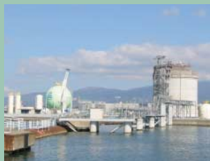
函館みなと工場(2006年春竣工予定)
