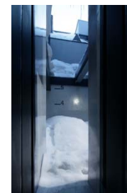
自然落雪式 貯雪システム
