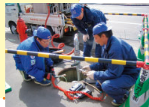
天然ガス転換作業の様子
