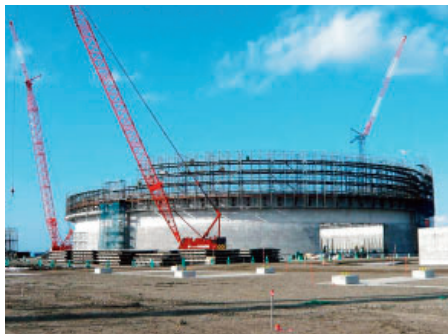
順調に工事が進む石狩LNG基地
