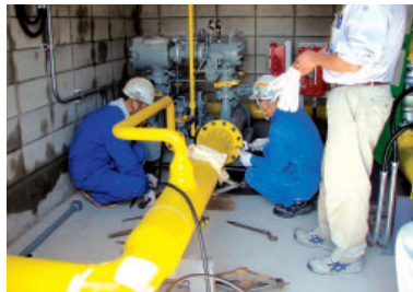
ガス配管工事
