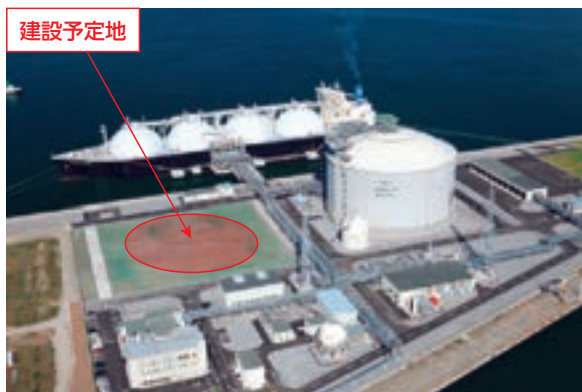
< LNG 2号タンクの建設工事開始 >
