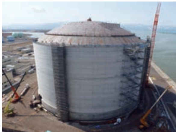
＜石狩LNG基地2号タンク建設工事中＞
