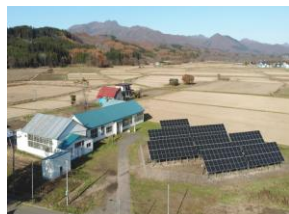
厚沢部太陽光発電所
