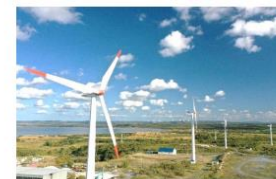
稚内風力発電所
