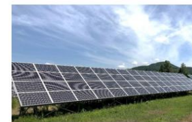
芦別太陽光発電所
