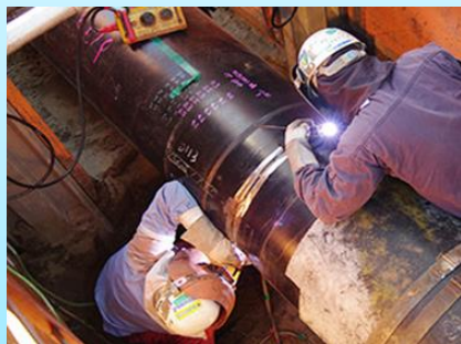
中圧ガス導管工事の様子
