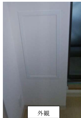
写真B：室内点検口（例）
