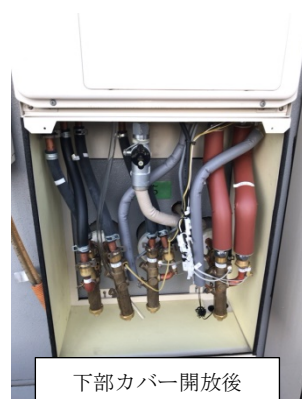
写真A：屋外設置ボイラー（F a c t）
