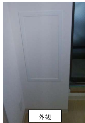
写真B：室内点検口（例）
