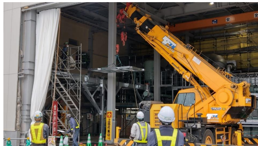
8月5日 屋内架台組立
