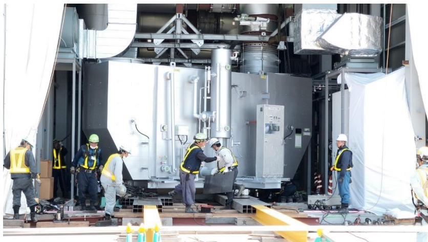
7月20日 排熱回収ボイラー搬入
