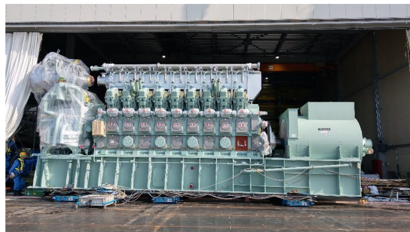
8月19日 ガスエンジン・発電機搬入
