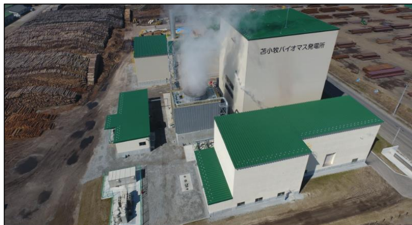
苫小牧木質バイオマス発電所
