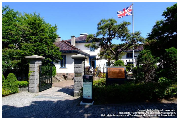
▲ 函館市旧イギリス領事館（外観①）
