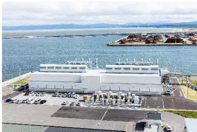
北ガス石狩発電所 ＜93,600kW＞
