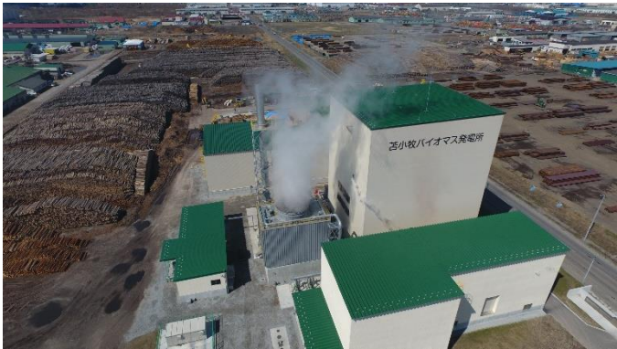
苫小牧バイオマス発電（道内産未利用木材を使用） ＜6,194kW＞
