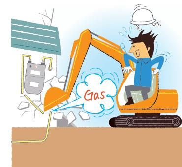
事例 4 整地作業中に敷地境界付近で一旦止めてあったガス管を損傷してしまった。(ガスが通っています)
