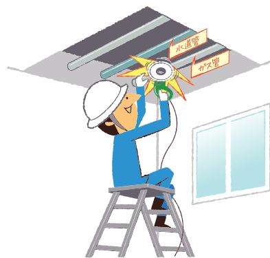
事例 2 掘削作業をしていたところ、ガス管を損傷してしまった。
