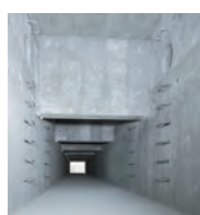
地下クールヒートレンチ
