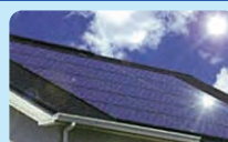
太陽光発電(住宅用)
