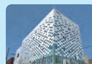
北ガス札幌発電所 (北ガスグループ本社ビル) 15,600kW
