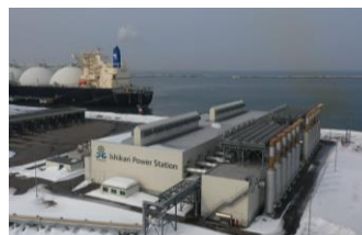
北ガス石狩発電所
