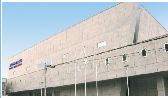
北ガスアリーナ札幌46 (札幌市指定基幹避難所)
