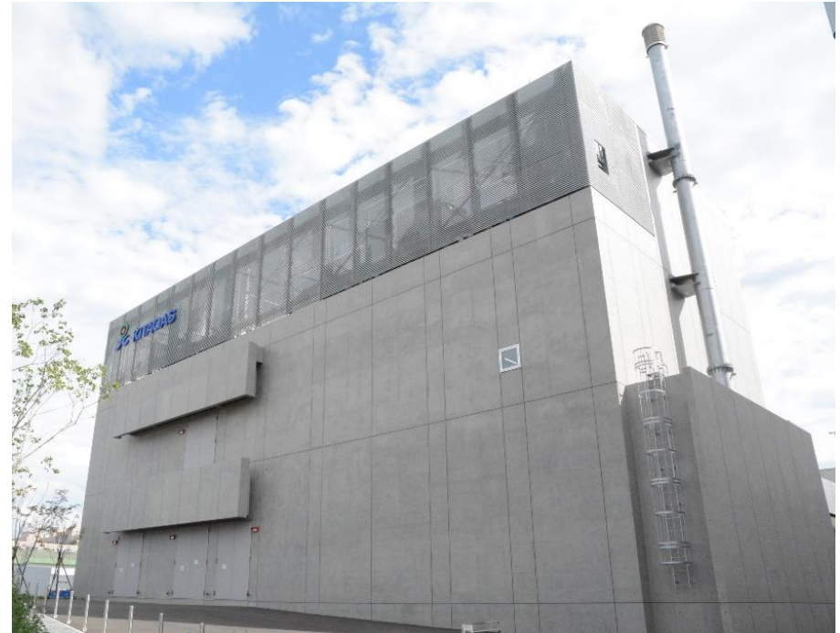
46エネルギーセンター
