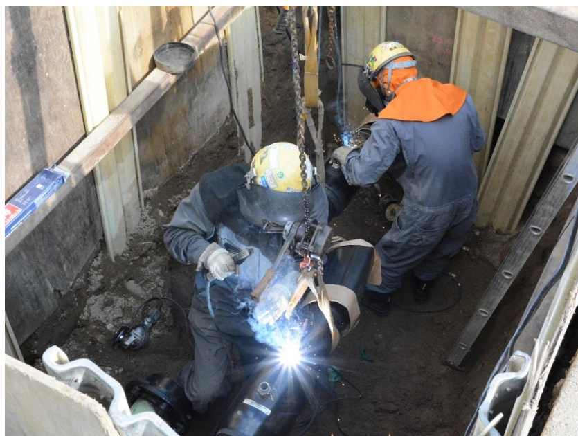
中圧ガス導管工事
