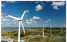
稚内風力発電所
