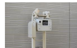
ガススマートメーター
