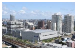
札幌市北4東6周辺地区における 地域エネルギーマネジメントシステム
