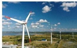
稚内風力発電所
