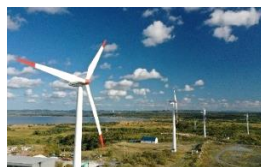
稚内風力発電所
