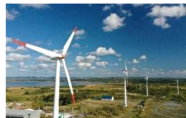
稚内風力発電所
