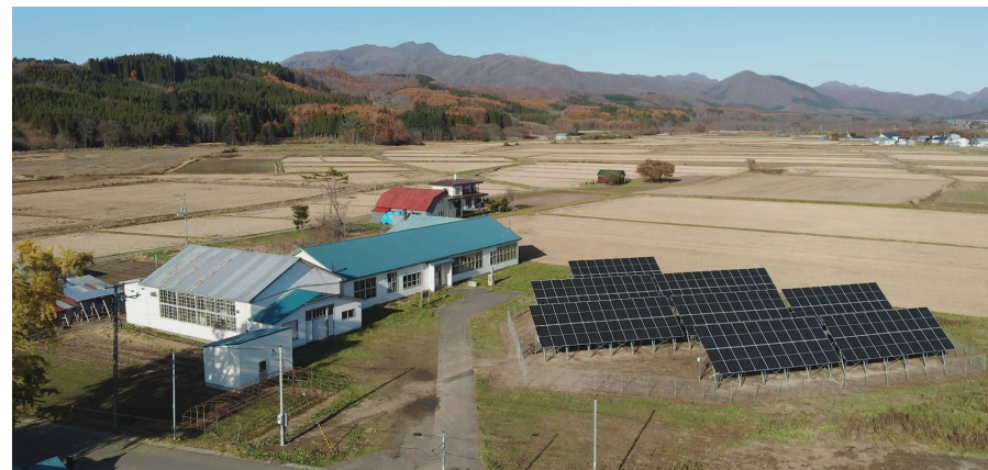
▲厚沢部太陽光発電所（左：第1発電所、右：第2発電所）
