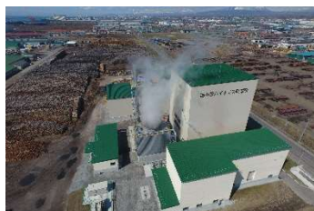
苫小牧バイオマス発電所 (2017年)
