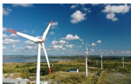
稚内風力発電所
