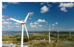
稚内風力発電所
