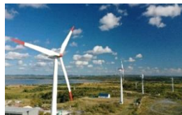
稚内風力発電所
